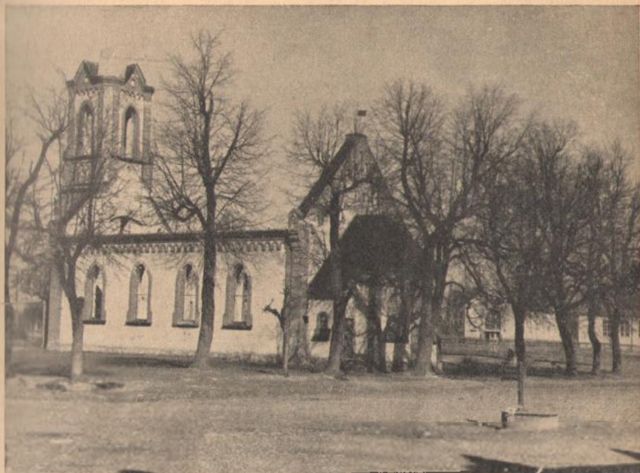
Die evangelisch-lutherische Kirche in Birsen nach ihrer teilweisen Zerstörung während des Zweiten Weltkrieges. Unsere Aufnahme wurde im Frühling 1961 gemacht, kurz vor ihrer endgültigen Zerstörung durch Spitzhacke, Preßluftbohrer und Planierraupe.
