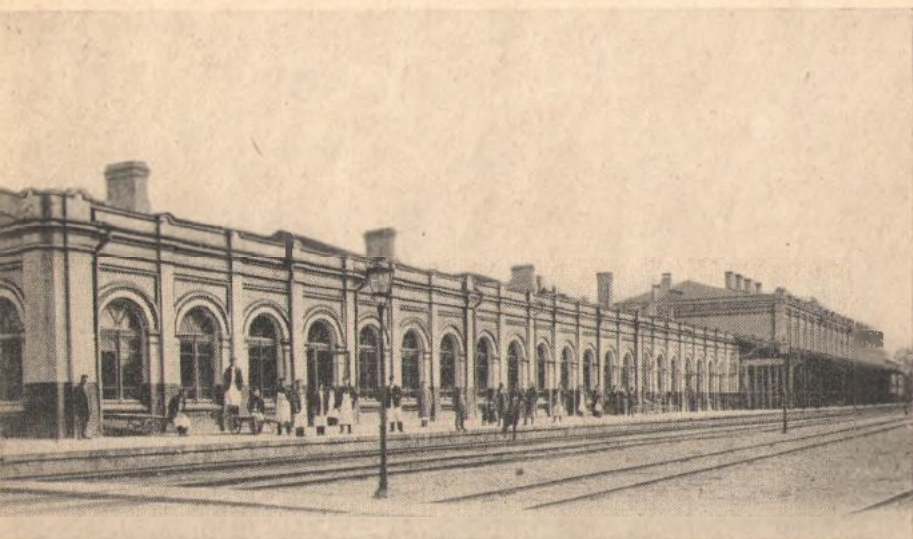
Der Bahnhof von Wirballen. Die überdimensionale Größe des Wirballer Bahnhofs erklärt sich aus der Tatsache, daß der Ort eine Grenzstation zwischen zwei mächtigen Reichen war, Rußland und dem Deutschen Reich. Der Bahnhof empfing und entließ Kaiser und Könige...
